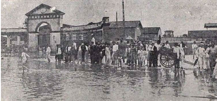
Figura 5: Antigo Matadouro Municipal.
