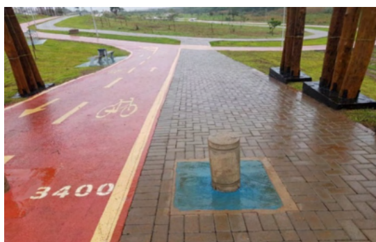
Figura 17: Acesso externo na zona A.
