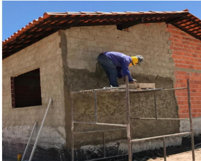
Figura 7. Aplicação da argamassa termoacústica
