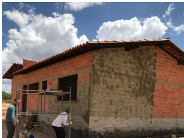
Figura 6. Foto aplicação do chapisco
